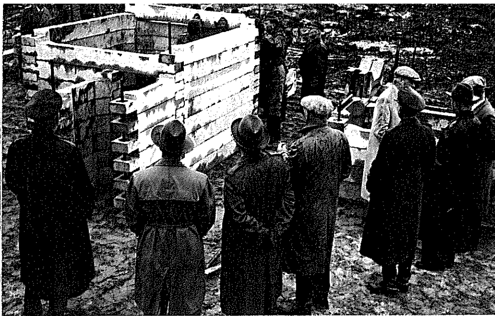
Rajaville Oy:n valmistamien elementtikorjujen pystytystä
