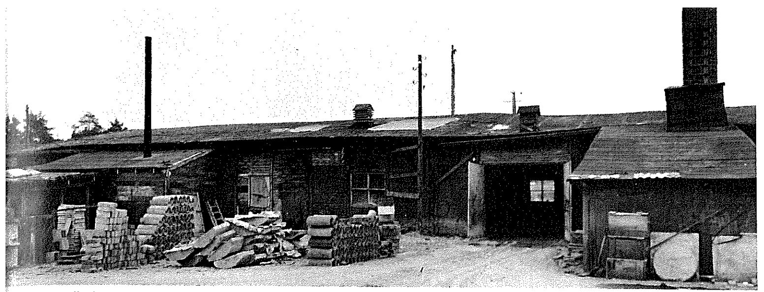
Rajaville Oy:n ensimmäinen tehdasrakennus ja konttori vv. 1950-1966.
