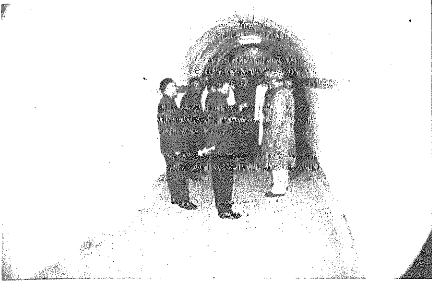
Tunneli Pekingin alla
