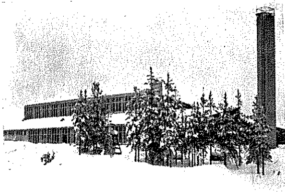
Tällaisia ovat puolustusvoimain uudet korjaamoraakennukset
