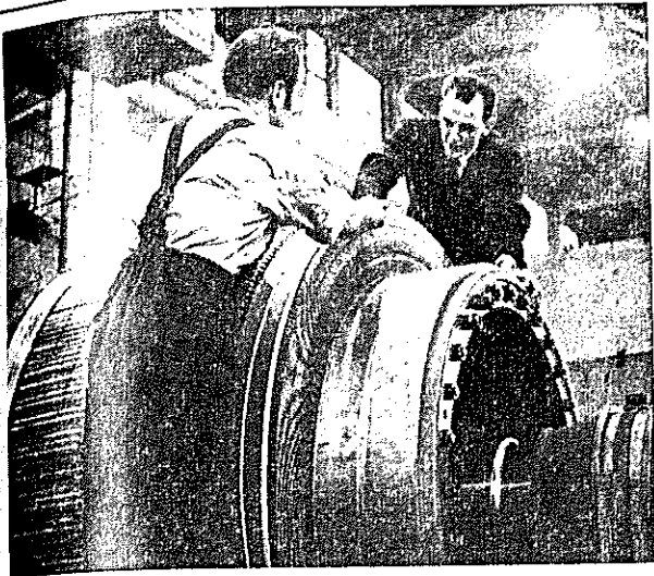
Kaapelinlaskualuksen potkurimoottorin roottori viimeisteltävänä Pitäjännämen tehtaalla.
